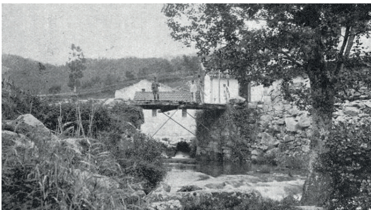
El puente internacional de Ponte Barxas fotografiado desde la orilla española en 1924 21
